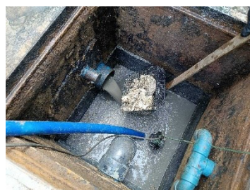
การตัดไขมันจากระบบบำบัดน้ำเสีย
