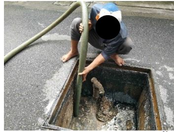
การสูบน้ำออกจากกระบบบำบัดน้ำเสีย
